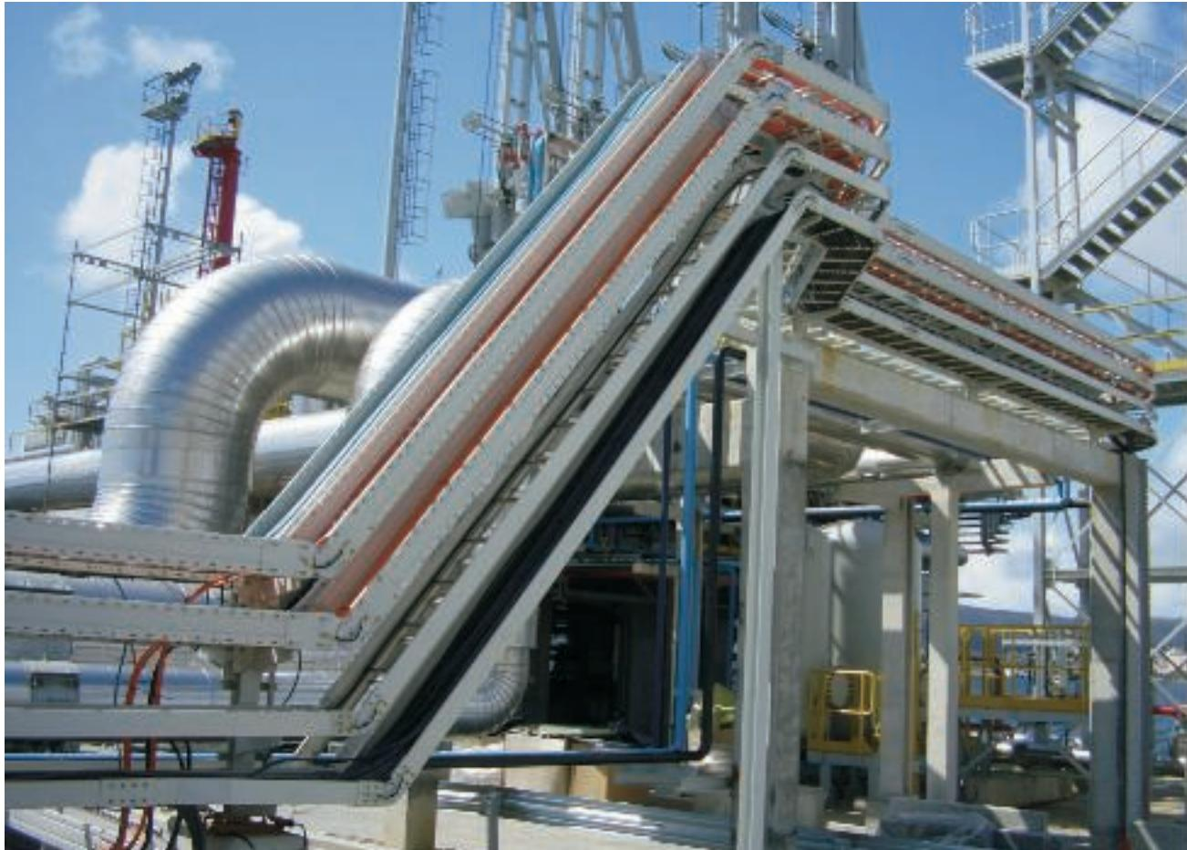
Для наружного монтажа и установки в помещениях, в условиях агрессивного атмосферного воздействия или в особых гигиенических условиях - для любого случая компания ОВО Bettermann предлагает кабеленесущие системы из соответствующего материала с оптимальным вариантом обработки поверхности.
